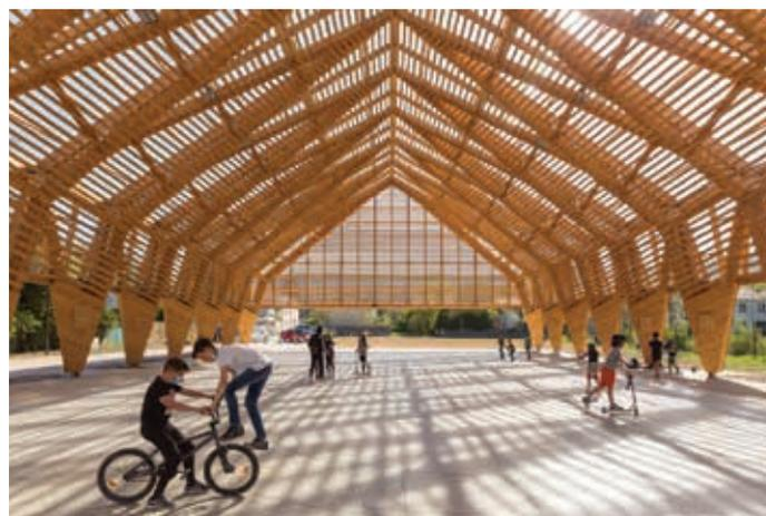
Ancy-Dornot, halle en bois : principe identique, mais aux dimensions 3 fois plus grandes (800 m<sup>2</sup>) que le projet proposé à Théding. Structure ombrière avec toiture transparente en polycarbonate.
