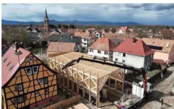
Muttersholtz, halle en cours de construction, dans une dimension légèrement plus petite à celle proposée pour Théding (200 m<sup>2</sup>). Structure bois, insérée dans un centre historique, toiture celle proposée pour Théding (200 m<sup>2</sup>) recouverte de panneaux photovoltaïques.
